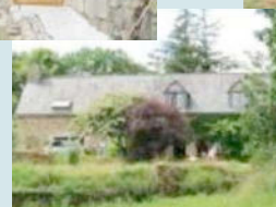
Le bâtiment principal
