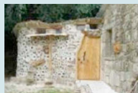
Les toilettes sèches
